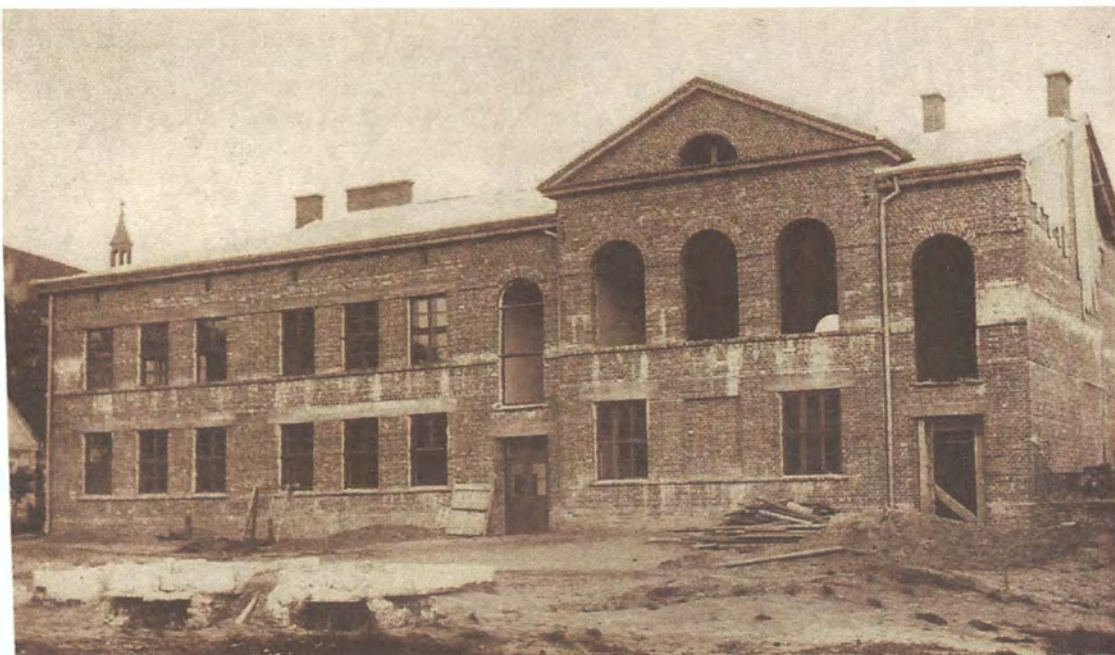
Gmach szkoły podczas budowy 1936 - 1937
